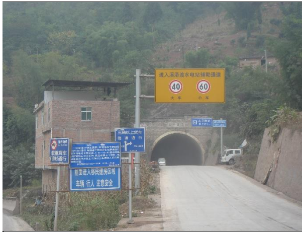
道路终点交通警示牌
