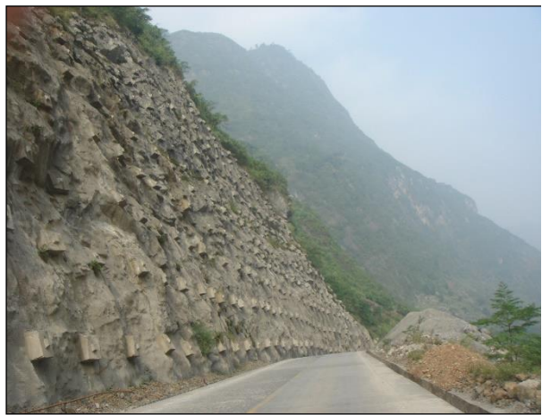
锚索喷混护坡
