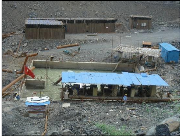
废水处理设施
