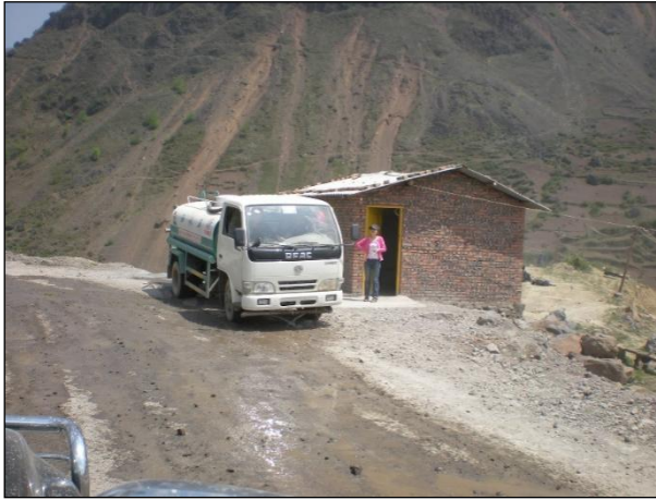
施工期洒水降尘
