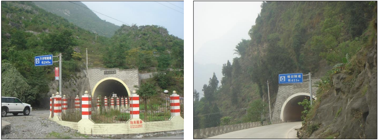
洞顶植被生长情况
