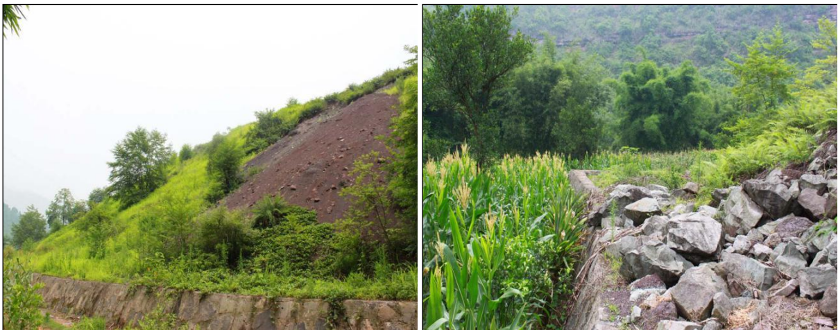
浆砌石挡墙完善
