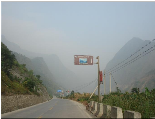
安家坪大桥前
