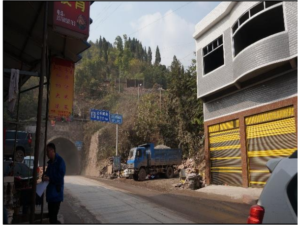
太平隧道(辅助道路终点)
